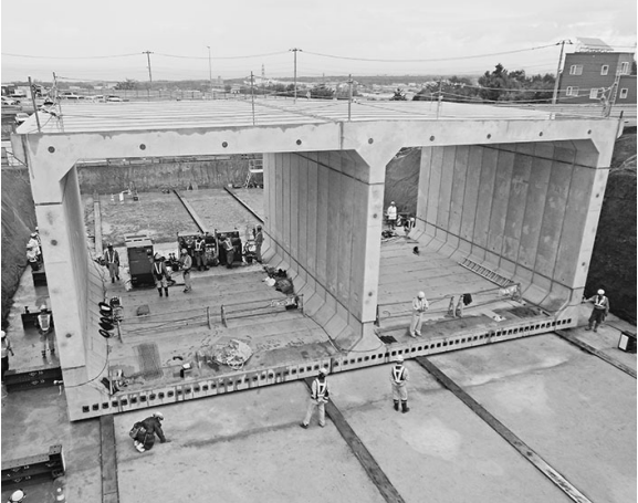
札幌自動車道鉄筋RC改築工事
