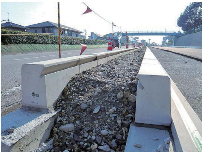
TIS)にも登録されている。歩車境界ブロック、L型街渠、落蓋U字型側溝などのコンクリート二次製品のほか、鋼製の排水溝などグレーチング製品もラインアップされている。特徴は、ブロック側面に切り欠け部を設けていること。植物には、重力を感知して根が下方向へ成長する「屈地性」と、芽や茎は光に向かって上方向に成長する「屈光性」という性質がある。このブロックを設置すると、切り欠け部分で根は上方向、芽は下方向へと本来とは逆の方向に進路を変えられ、植物は自然に成長を止めるといふ。既存のブロックに切り欠け部を設けるだけなので、環境への悪影響がない。
