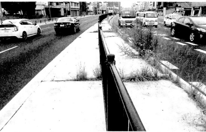
防草ブロックを使用した箇所(左)と通常のブロック。防草ブロックで草の伸びが抑えられている
