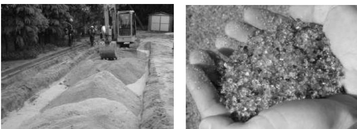
廃棄・埋立処分されていた色付きのガラス瓶や陶磁器くずを100%原料とし、製造工程で破碎・エッジレス化することにより、良好な透水性・防草性能を持った造粒砂。
