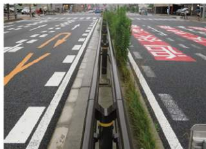
写真-3 防草ブロック (左側)
