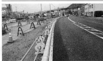
スラットと側溝の施工状況
